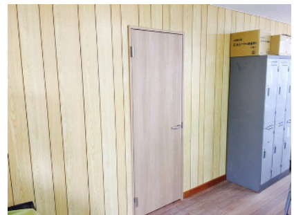
(工事後)作業室にトイレへのドアを増設
