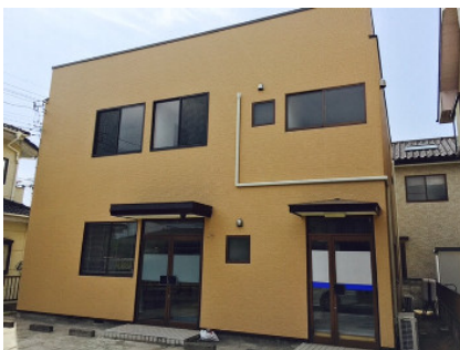
綺麗な壁に張り替えられた建物
