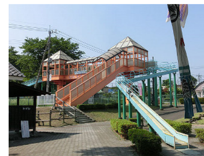
公園を象徴するローラーコースター付歩道橋
