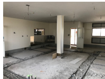
改装中の麦のゆめの新厨房
