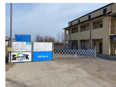
建設現場に看板が立ちました
